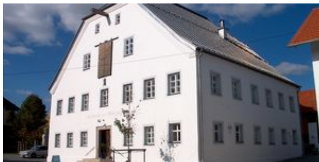
Infostelle "Würzinger Haus" in Außernzell
